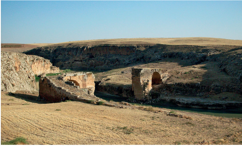
Fig. / Res. 15a CNMP, Kızilin Bridge, CNCDP Archive, 2011. KNYP, Kızilin Köprüsü, KNKGP Arşivi, 2011.
